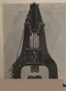
6 TON DOUBLE FRAME HAMMER.
